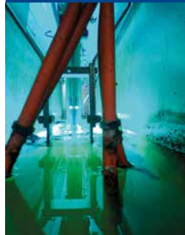
PRIMER MONTAŽE IN UPORABE UV REAKTORJA PRI DEZINFEKCIJI ODPADNE VODE V KANALU
