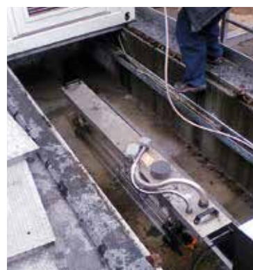
PRIMER MONTAŽE IN UPORABE UV REAKTORJA PRI DEZINFEKCIJI ODPADNE VODE V KANALU
